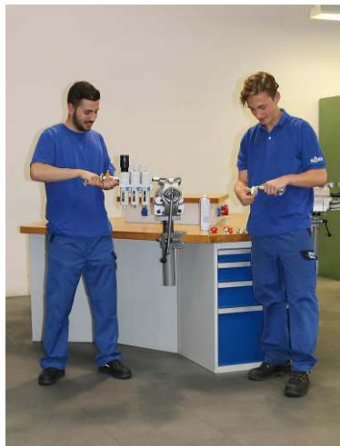
Installieren einer neuen Wartungseinheit
